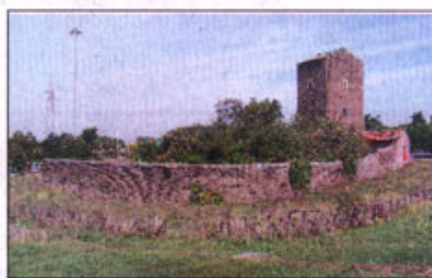
La torretta da recuperare dal degrado
